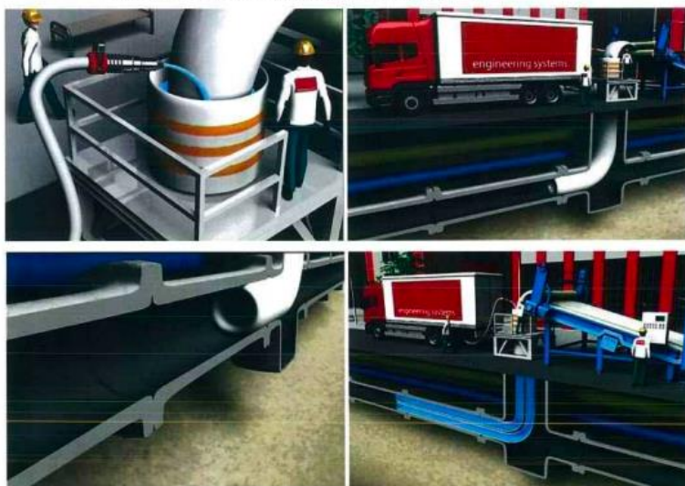
Рисунок 10, 11, 12, 13. Ввод рукава в трубопровод
