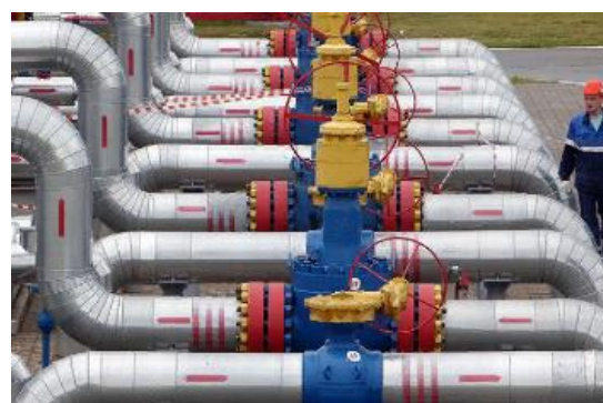
Защита изоляции трубопроводов
