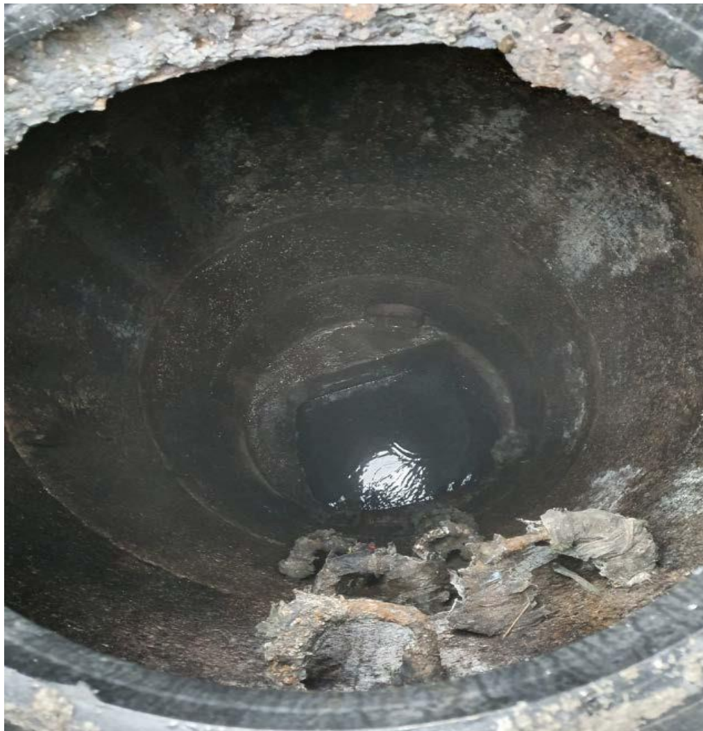
Фото №1. Вид внутренней поверхности колодца ДО ремонтных работ.
