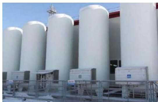
Антикоррозийная защита и ремонт резервуаров
