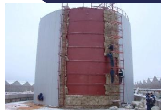
Защита теплоизоляции резервуаров
