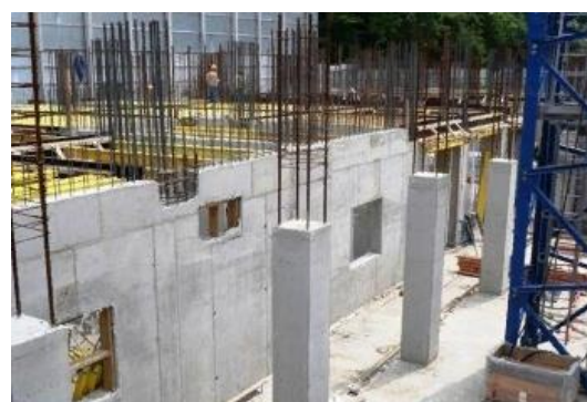
Восстановление бетонных конструкций
