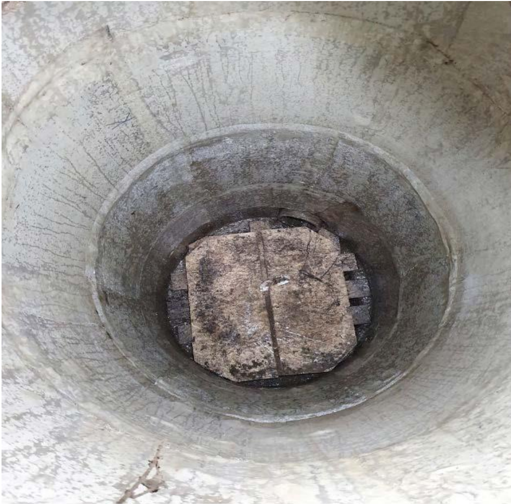
Фото №2. Вид внутренней поверхности колодца ПОСЛЕ ремонтных работ. Колодец сухой.
