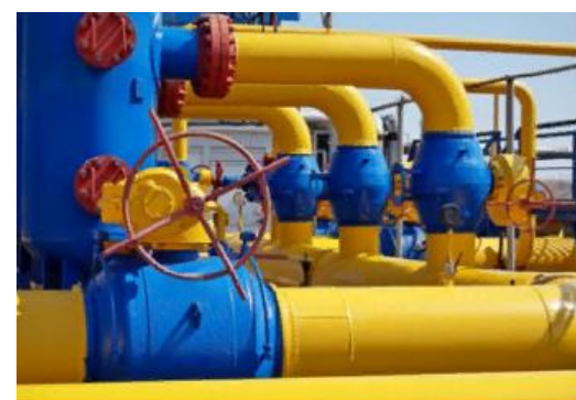
Защита газопровода от коррозии
