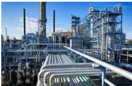
Антикоррозийная защита металлоконструкций
